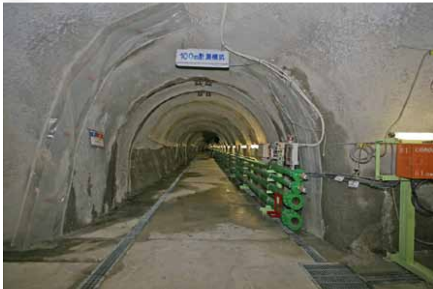
【深度300m研究アクセス坑道（100m計測坑道）】
