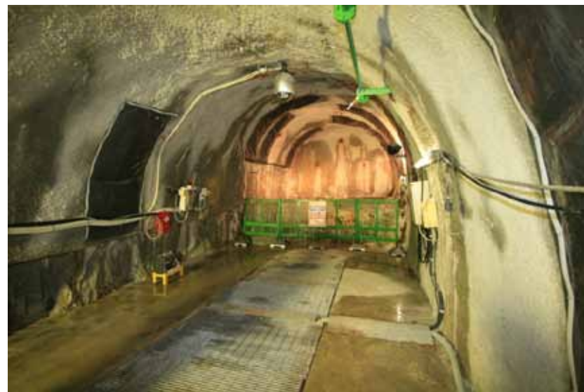
【深度300mボーリング横坑(換気立坑)】
