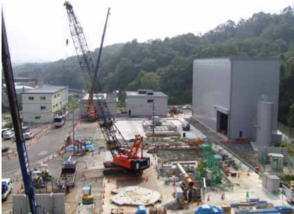
9月9日現在 管理棟屋上からの様子
