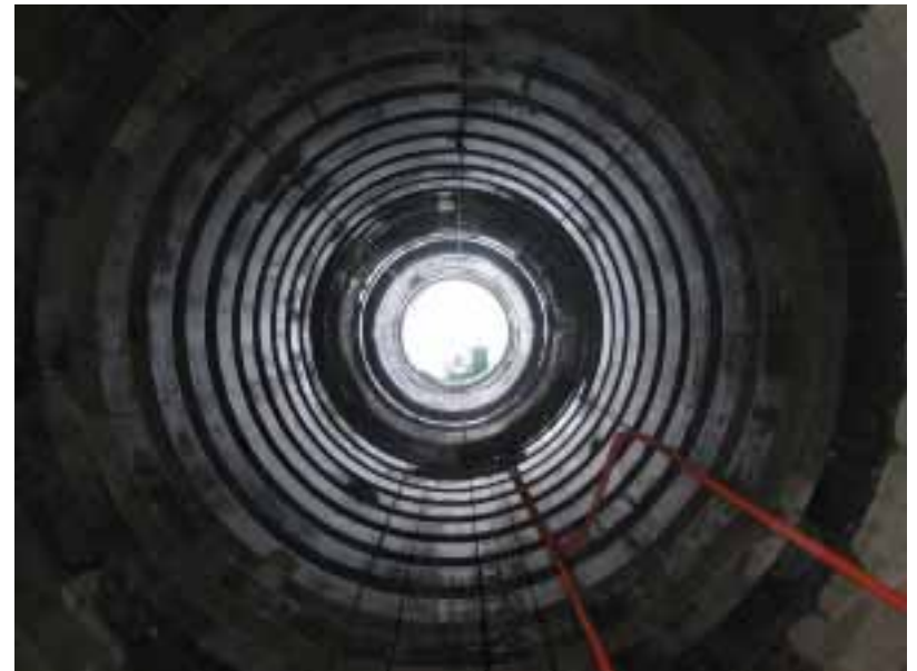
坑底からの様子
