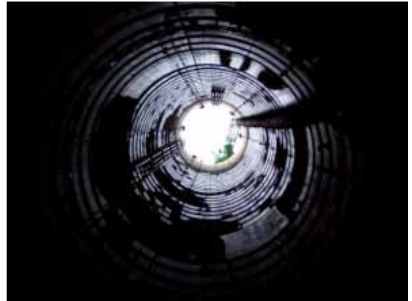
坑底からの様子
