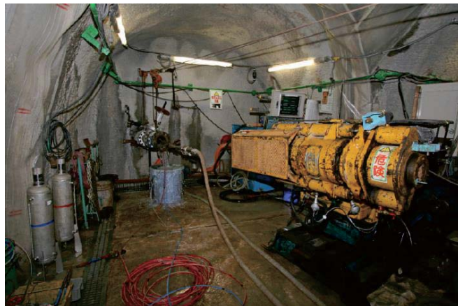
地下水の水質観測ボーリング孔 産業技術総合研究所との共同研究 (深度300m研究アクセス坑道 100m計測横坑)
