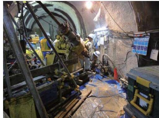
岩盤中の物質の移動に関するボーリング孔 電力中央研究所との共同研究 (深度 300m ボーリング横坑 (換気立坑))
