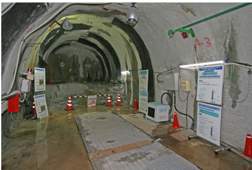
【深度300mボーリング横坑（換気立坑）】
