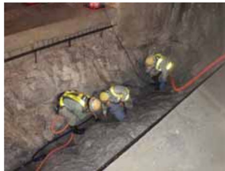
①坑道掘削後(左写真)に、止水壁の設置部分を掘り込んで掘削します(右写真)。
