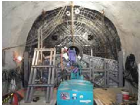
③作業や研究者が冠水坑道に行き来できるようにするためのマンホールを設置(左写真)した後、鉄筋組立、型枠設置と進めていきます(右写真)。
