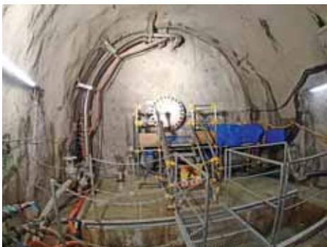
⑤止水壁前面の配管や水槽を設置した後、止水壁の機能確認試験を実施しました。右は、冠水坑道内で水が溜まる状況の写真です。
