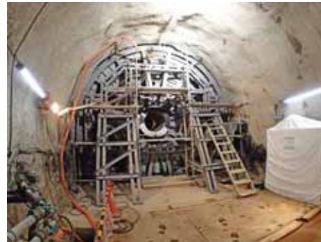
④型枠の完成後(左写真)、止水壁の状態をモニタリングできるセンサー類を型枠の中に設置し、コンクリートを流し込みます。その後、コンクリートが硬化してから型枠はずします(右写真)。
