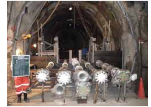
②止水壁の型枠を設置(左写真)するとともに、採水のためのチューブやモニタリングデータを取るためのケーブルを入れる貫通管を設置(右写真)します。
