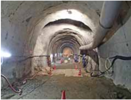
①坑道掘削後(左写真)に、止水壁の設置部分を掘り込んで掘削します(右写真)。
