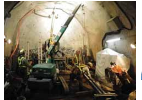
④型枠の完成後(左写真)、止水壁の状態をモニタリングできるセンサー類を型枠の中に設置し、コンクリートを流し込みます。その後、コンクリートが硬化してから型枠はずします(右写真)。
