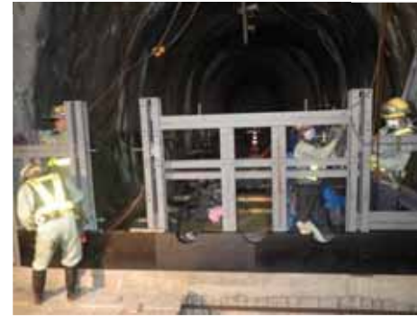
②止水壁の型枠を設置(左写真)するとともに、採水のためのチューブやモニタリングデータを取るためのケーブルを入れる貫通管を設置(右写真)します。
