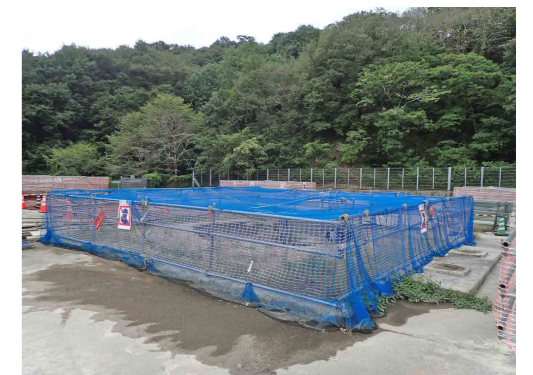
沈下部を埋め戻し後の立坑 ※青色のネットは坑口への人等の侵入を防ぐための安全ネット
