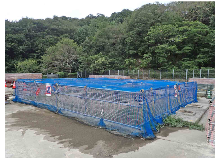
沈下部を埋め戻し後の立坑 ※青色のネットは坑口への人等の侵入を防ぐための安全ネット
