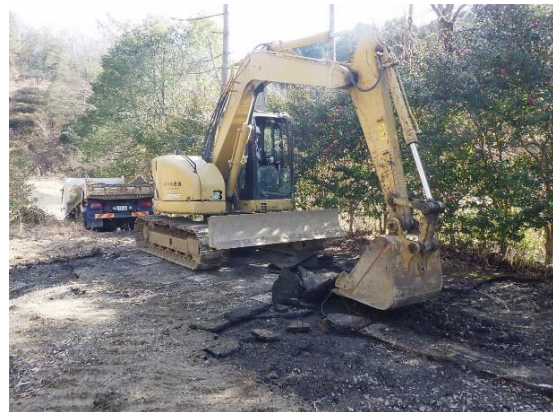
旧受変電設備の基礎撤去 (令和 5 年 1 月)
