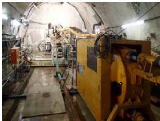
冠水坑道への埋め戻し材の充填 (手前の黄色の装置は埋め戻し材の圧送装置)
