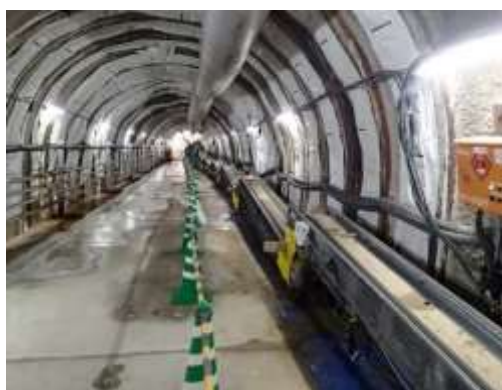
埋め戻し材(砂)運搬 (深度 500m 研究アクセス北坑道)
