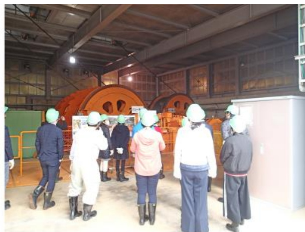
施設見学会 (主立坑側 巻上機室)
