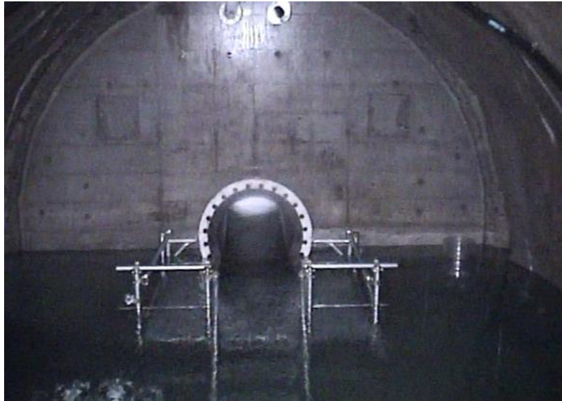
図5 止水壁の機能確認試験における冠水坑道内の状況(貯水中)
