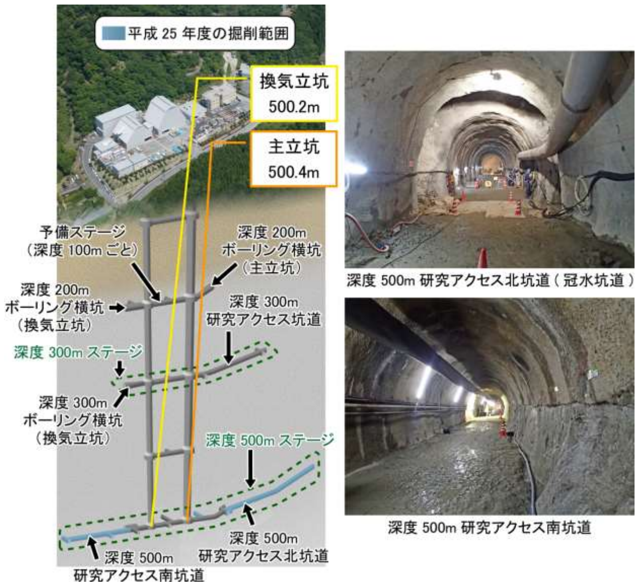
図 1 研究坑道の掘削状況
