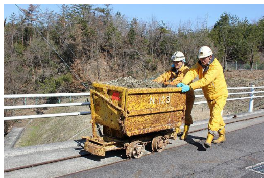
充填用捨石の搬入作業
