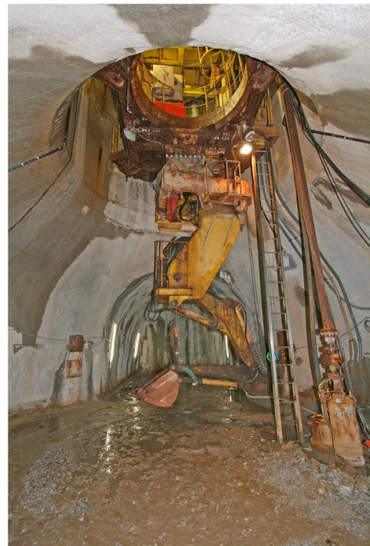
換気立坑 (深度 500.2m)
