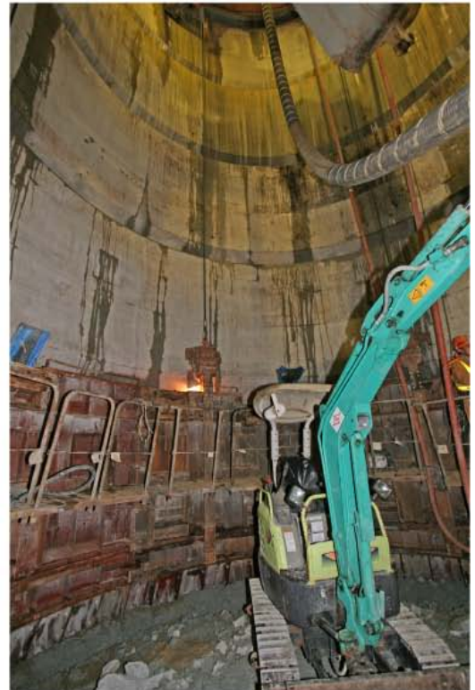
主立坑 (深度 467.1m)
