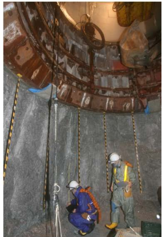
換気立坑 (深度 490.4m)
