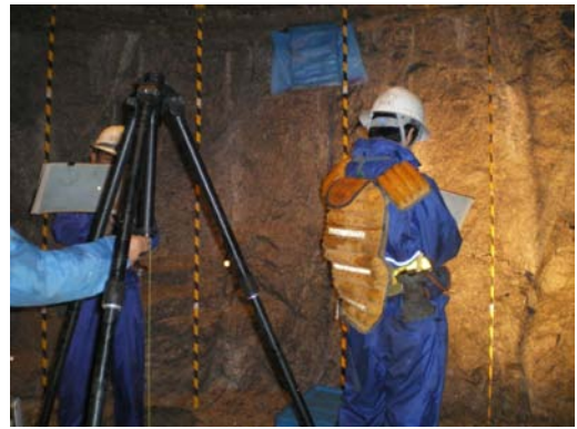
坑道壁面の調査(換気立坑深度360m付近)
