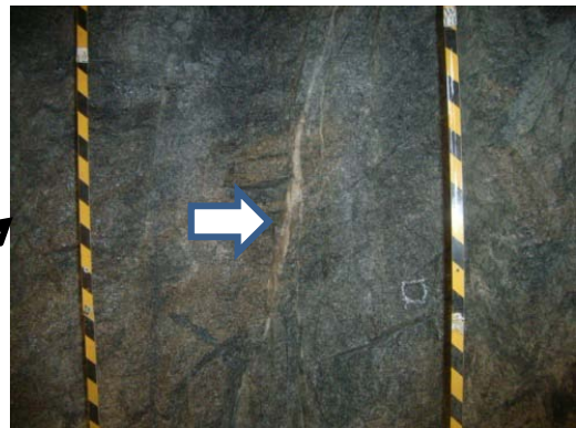
割れ目(換気立坑深度408m付近: 石英や方解石により充填されている)
