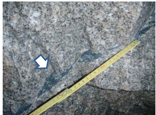
立坑の掘削に先行して注入した グラウト材が認められた割れ目 (換気立坑深度456m付近)
