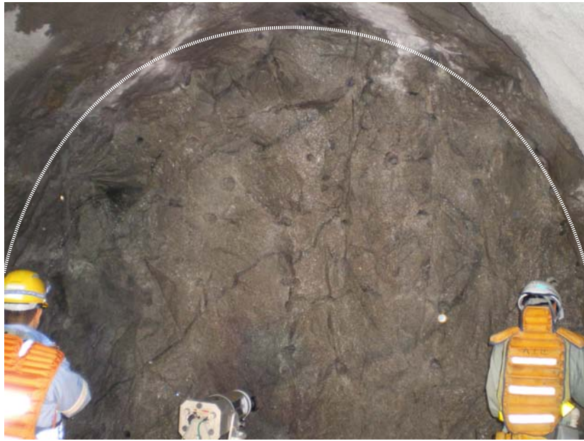
図1 壁面調査(深度 300m 研究アクセス坑道)
