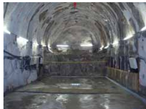
ボーリング横坑 (主立坑側)
