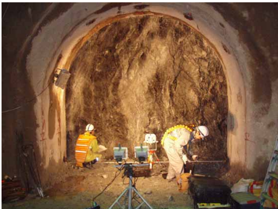
図2 壁面調査の様子
