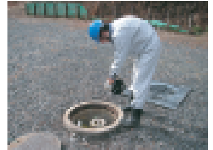
地下水の水位観測
