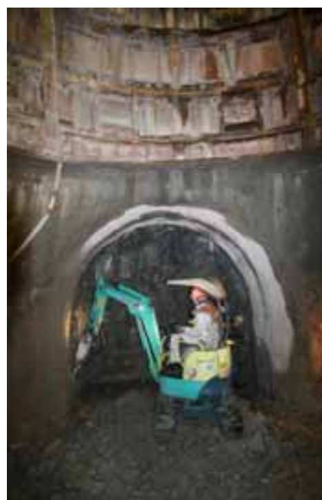
200m予備ステージ掘削工事の様子
