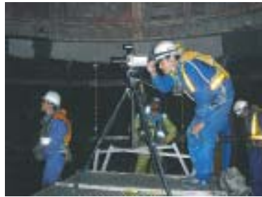
坑道壁面の観測
