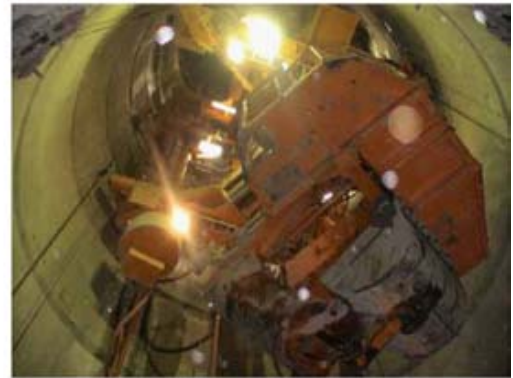
主立坑の坑底から見える掘削設備
