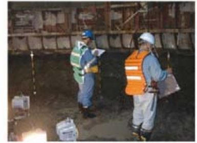
壁面地質観察状況
