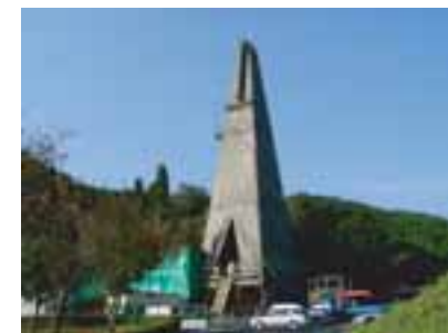
深層ボーリング調査
