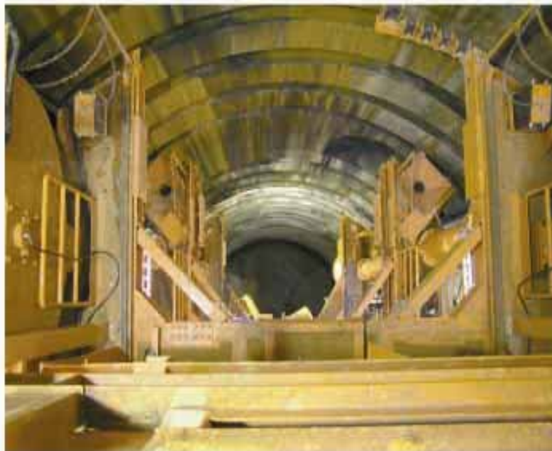
主立坑スcaffold（作業用吊り足場）
