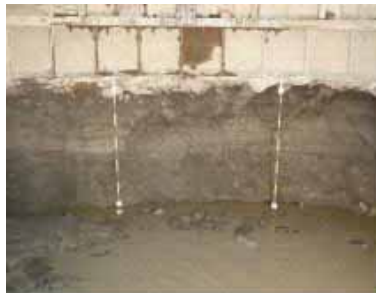
立坑壁面状況
