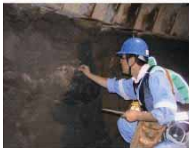
立坑壁面の観察風景
