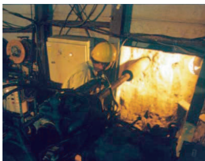
坑道におけるボーリング掘削作業
