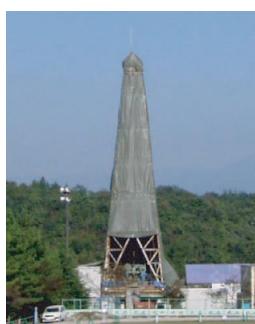
深層ボーリング調査
