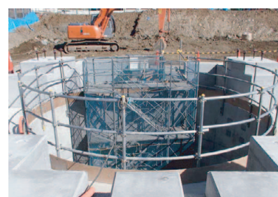
立坑坑口上部工（主立坑）
