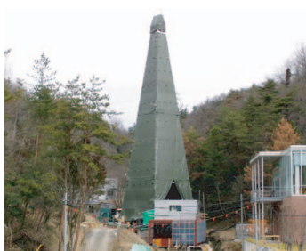
深層ボーリング調査
