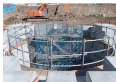
立坑坑口上部工（主立坑）
