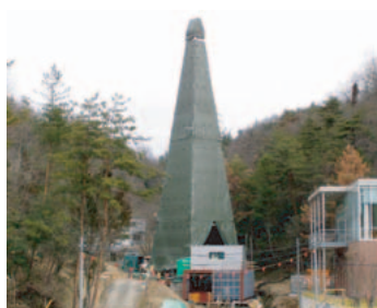
深層ボーリング調査
