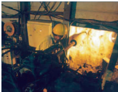
坑道におけるボーリング掘削作業
