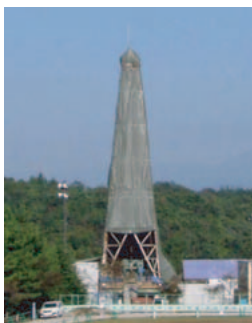
深層ボーリング調査
