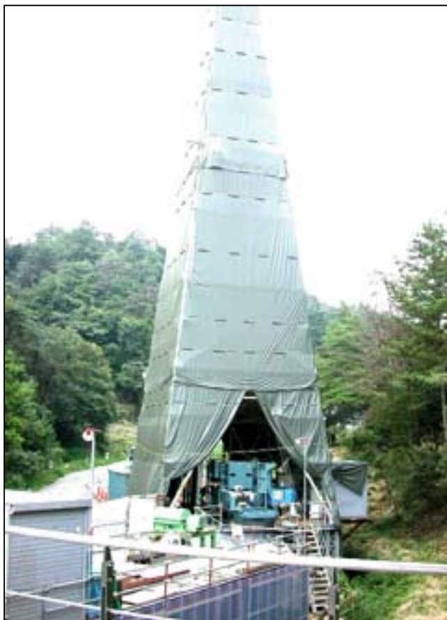
深層ボーリング調査現場風景 [予定掘削長：1,350 m] (2003年3月掘削開始)
