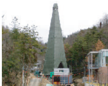
深層ボーリング調査
