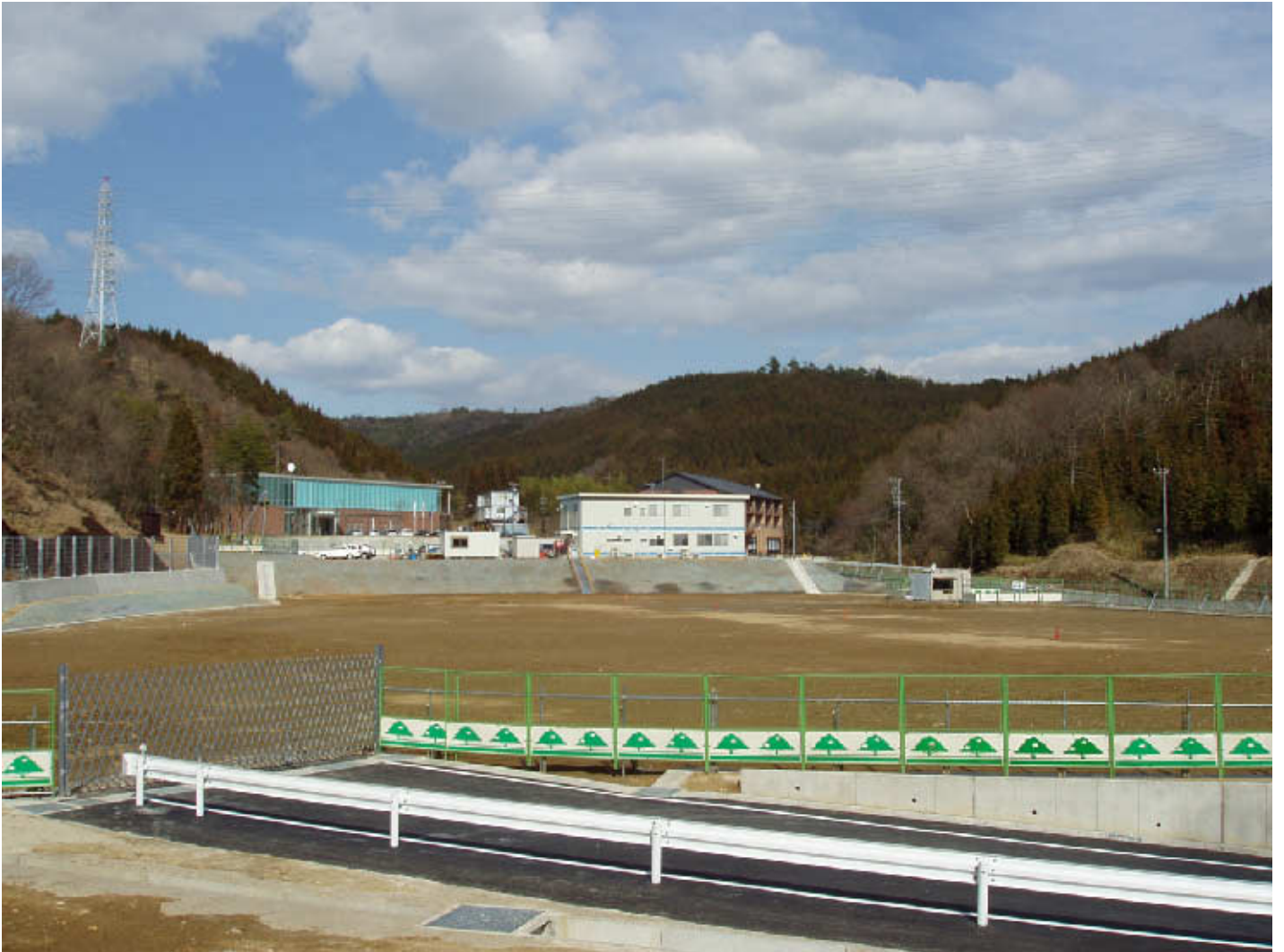
図6 瑞浪超深地層研究所の造成の状況
