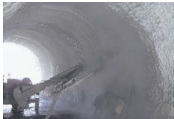
低アルカリ性コンクリートの吹付試験
