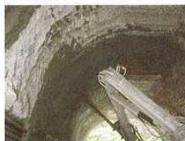
吹付けコンクリートの模擬施工状況
