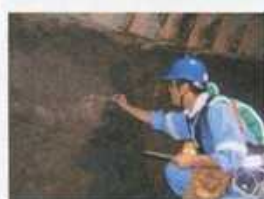
立坑壁面觀察狀況
