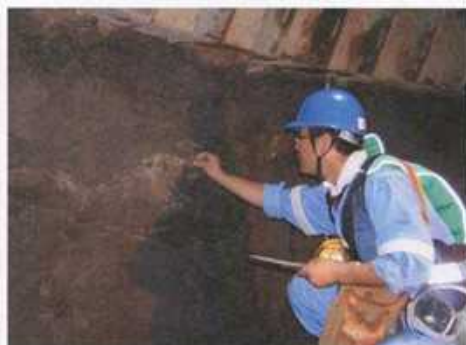
立坑壁面観察状況
