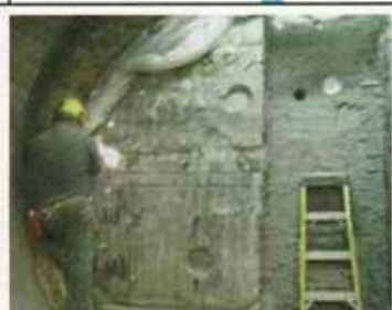
AECL地下研究施設における トンネルシーリング試験
