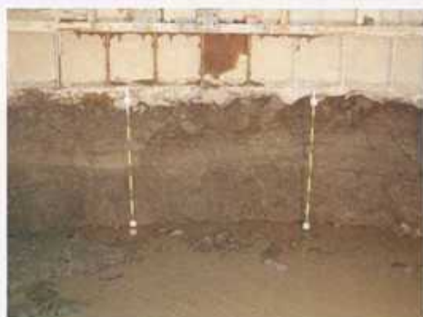
立坑壁面状況
