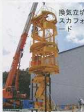
施工状況 (坑口部 GL-51.0m)
