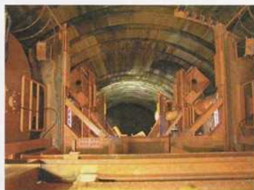
↑ 櫓からの眺め (換気立坑)
