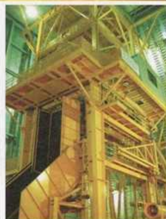
→ 櫓全景 (主立坑)
