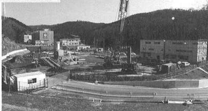
主立坑掘削状況
