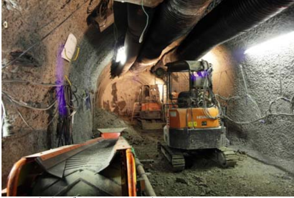
切羽掘削：ブレーカーによる掘削とバケットによる掘削土(スリ)の積み込み
