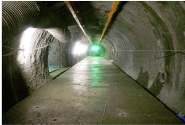
完成直後の調査坑道
