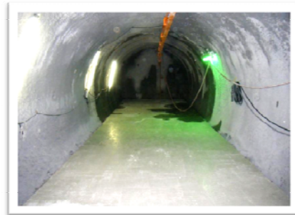
坑道仕上がり状況
