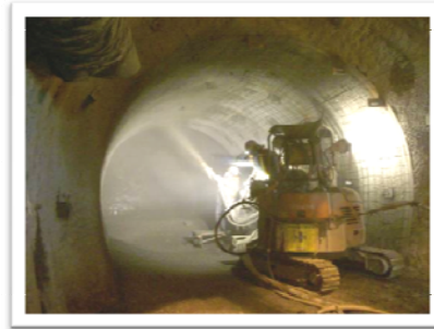
吹付け施工の様子
