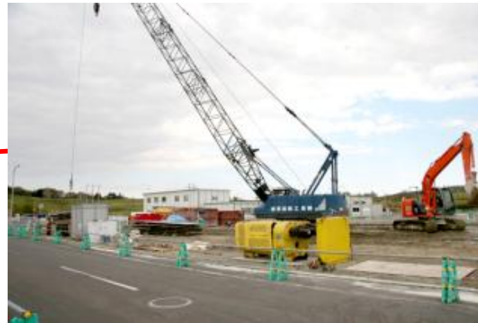
西立坑坑口止水連壁工事 (平成22年10月14日)
