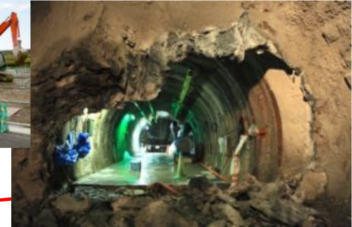
東立坑と換気立坑間の深度250m水平坑道の貫通 (平成22年6月23日)
