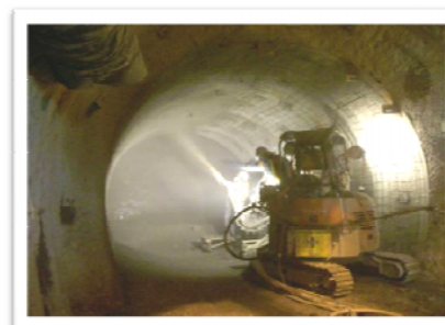
吹付け施工の様子
