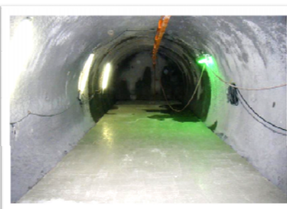
坑道仕上がり状況
