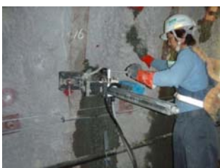
HFSC施工壁面からの コア採取
