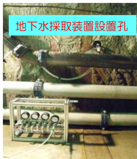
地下水採取装置設置
