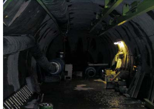
換気立坑より南南東方向へ掘削
