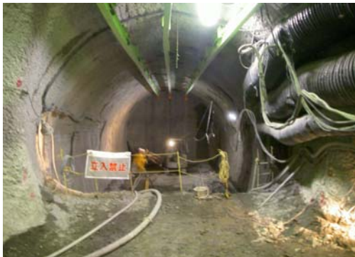
換気立坑より西方向へ掘削【大型試錐座】
