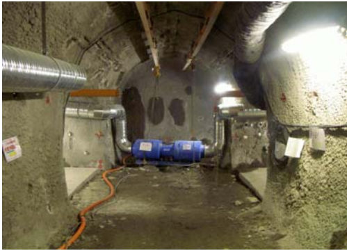
東立坑より北北西方向へ掘削
