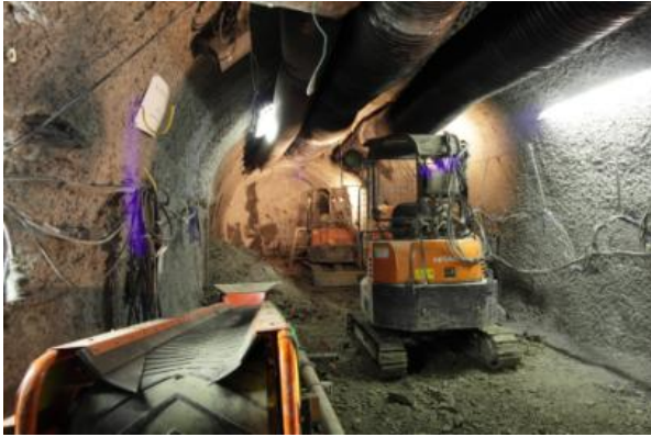
切羽での掘削:ブレーカーによる掘削とバケットによる掘削土(ズリ)の積み
