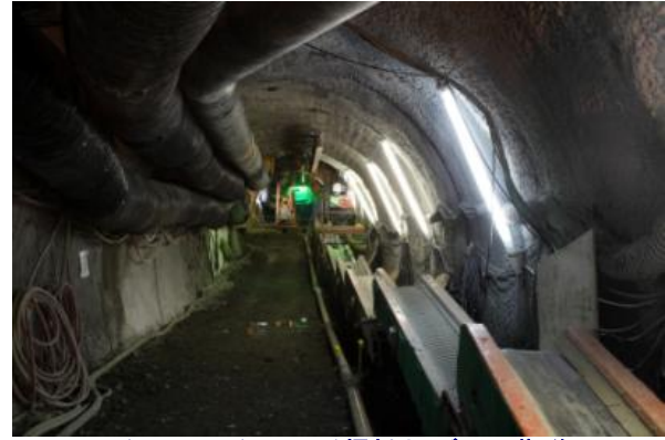
ベルトコンベヤによる掘削土(ズリ)の搬送
