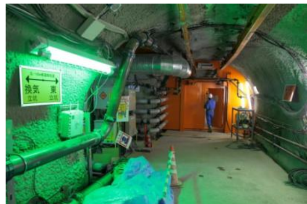
風門や配管等の設置
