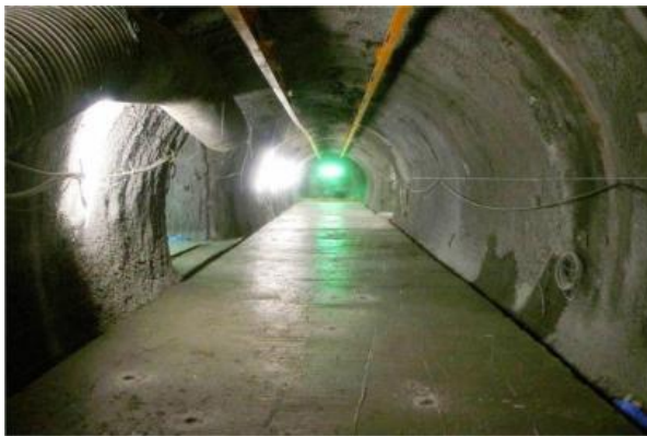
掘削完了直後の調査坑道
