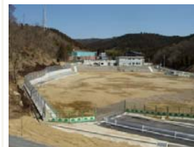
2003(平成15)年7月 地上部 立坑坑口掘削工事着工
