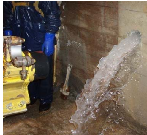
湧水状況（湧水量約500ℓ/min）
