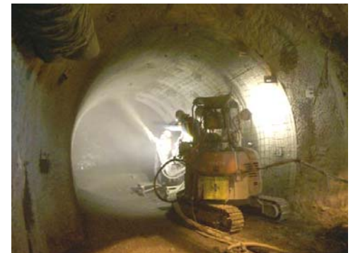
吹付け施工のイメージ (通常の吹付けコンクリート施工の様子) 33
