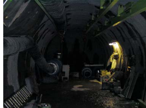
換気立坑より南南東方向へ掘削
