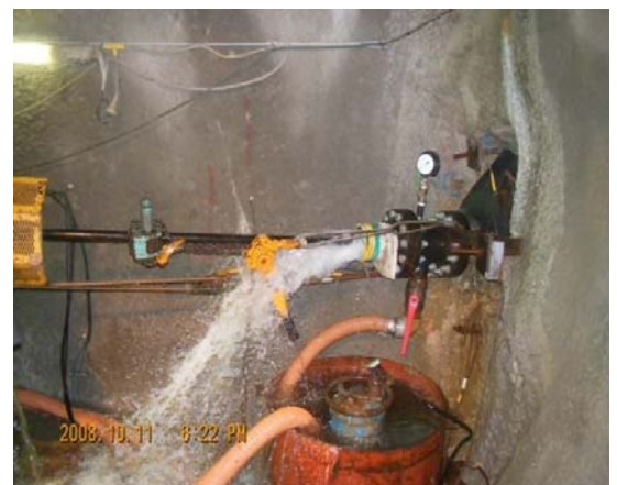
パッカー挿入作業 (湧水量: 1,200ℓ/min)
