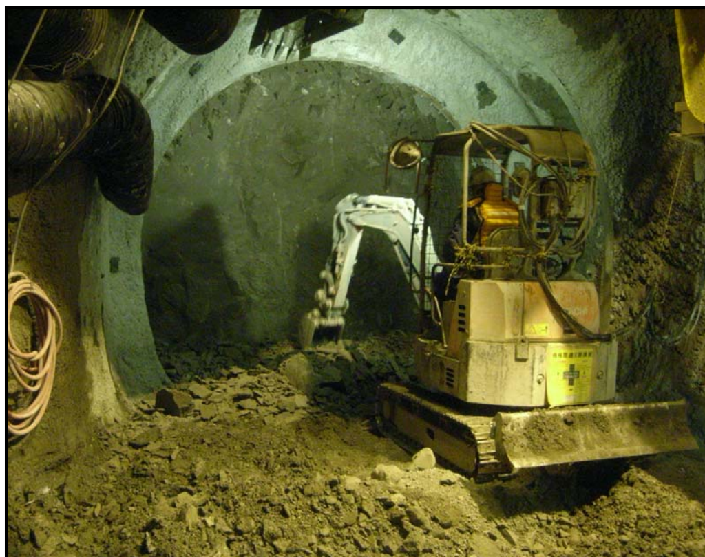
小型バックホウによる掘削：換気立坑（深度140m）
