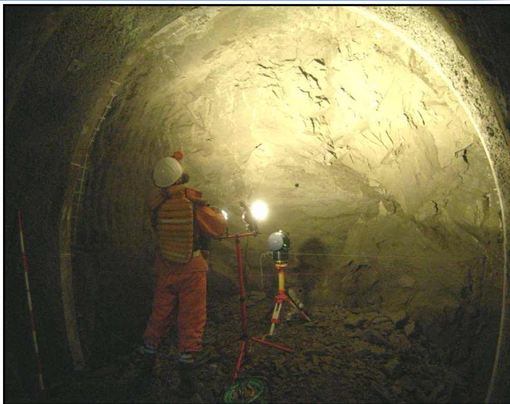
換気立坑：深度140m（水平坑道）
