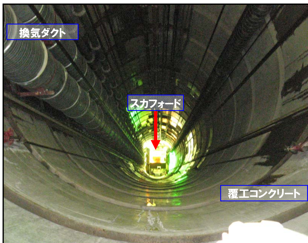
深度70mから坑底を望む
