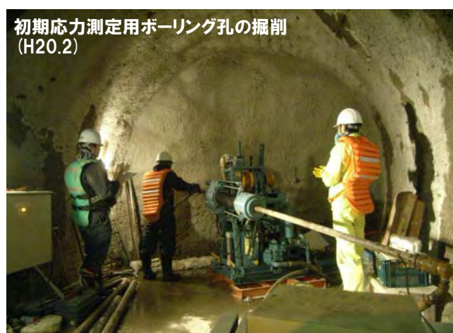
換気立坑140m小型試錐座
