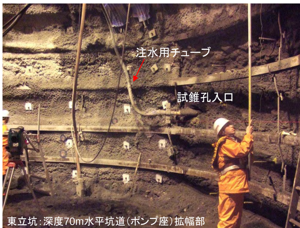
東立坑: 深度70m水平坑道 (ポンプ座) 拡幅部 坑道掘削に伴う岩盤の透水性の変化を調べるための水理試験 (H19.10.22)
