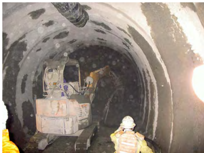
吹付コンクリート施工状況
