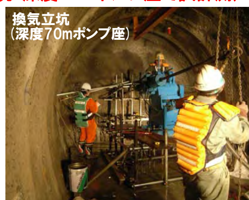
測定用ボーリング孔の掘削の様子
