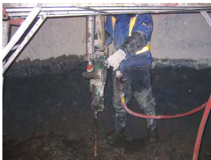
ガスチェックボーリング掘削
