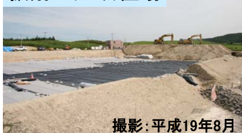
掘削土(ズリ)置場
