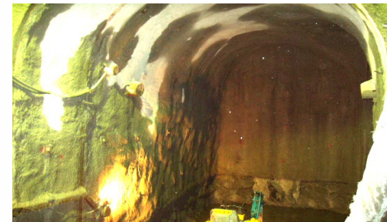
ボーリング横坑
