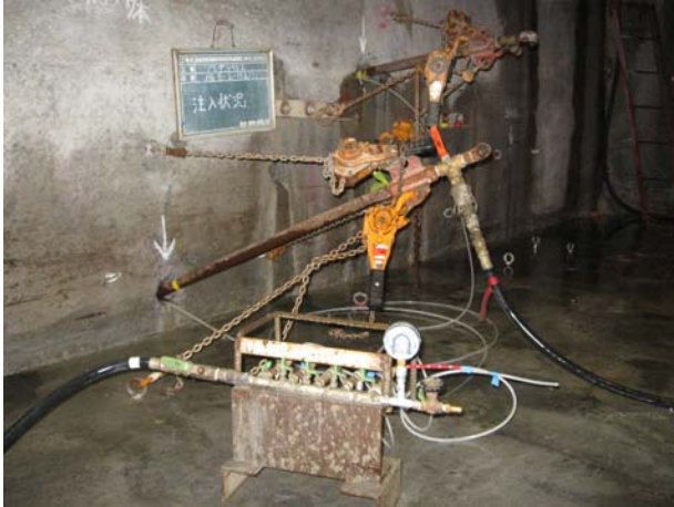
グラウト注入状況
